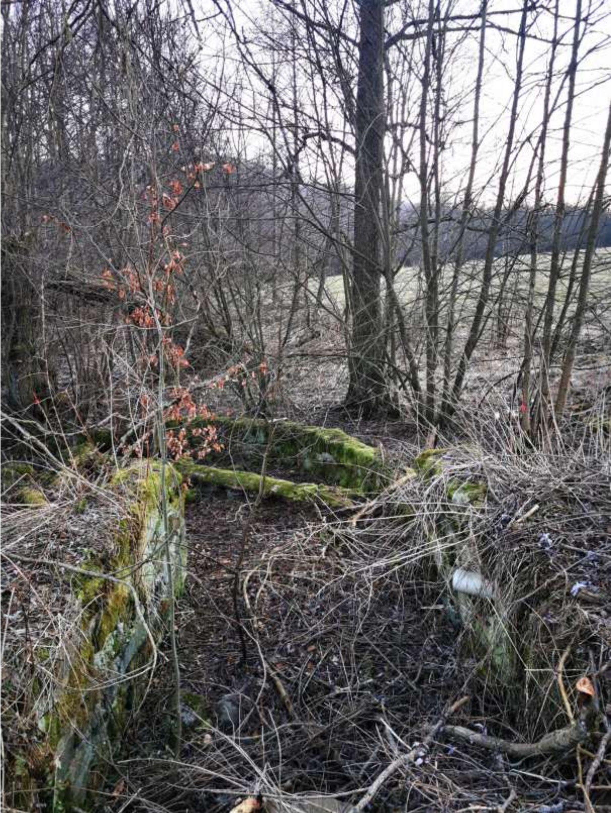
Pohled na koryto výtoku
