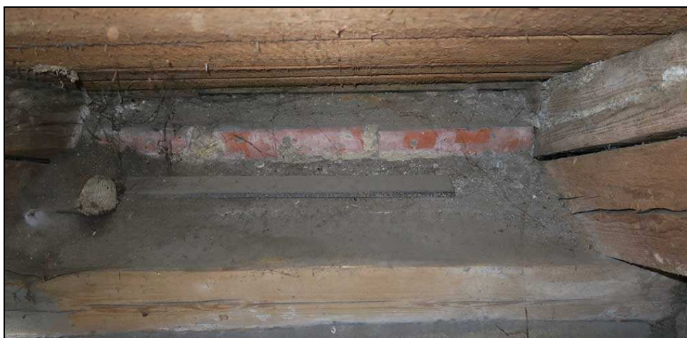
Prostor na pozednici je ze strany pů- dy otevřený, z vnějšku je zcela uza- vřen.
