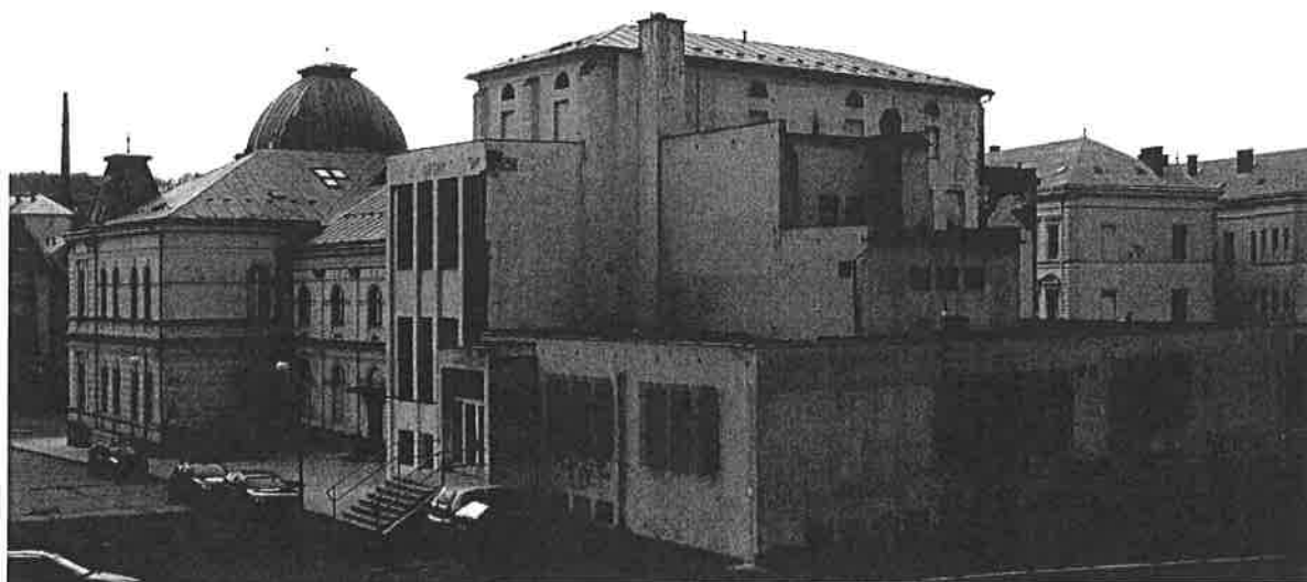
Pohled od severovýchodu
